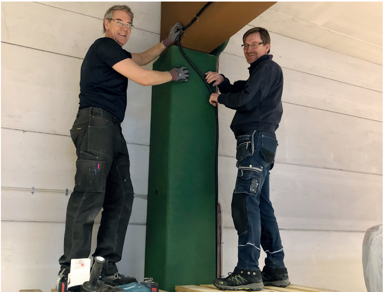
Förvaringsutrymmet på loftet färdigställs. Leif, fastighetsansvarig till vänster i bild och Mats, tekniker till höger.
